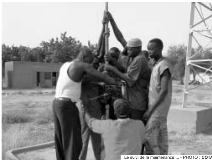
Le suivi de la maintenance ... - PHOTO : COTA
