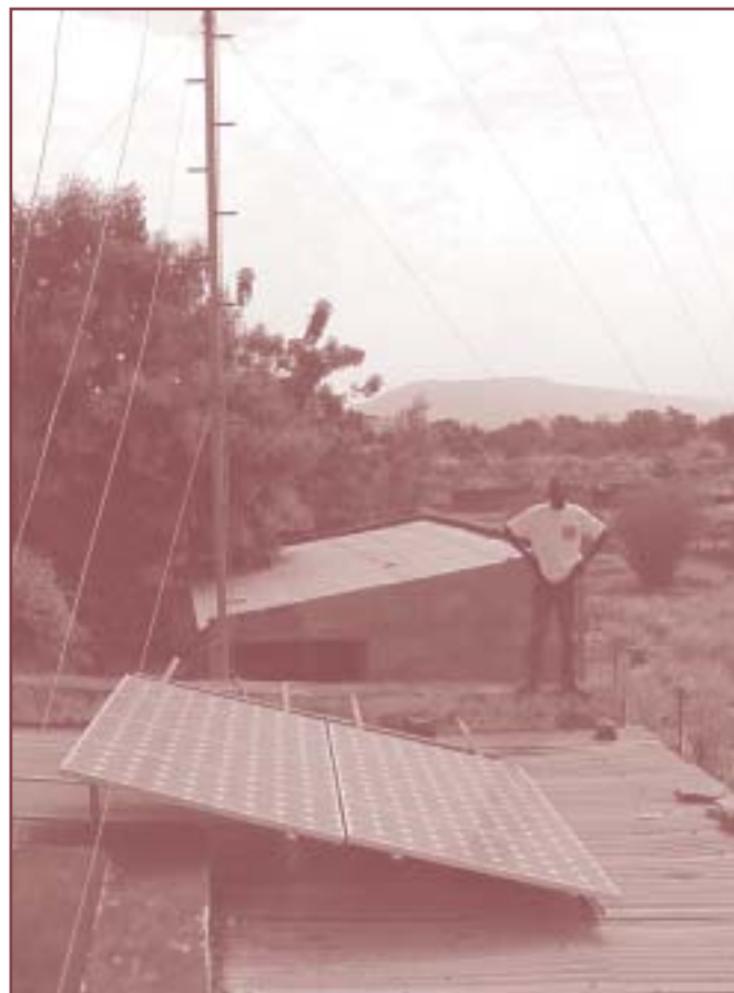
Antenne et panneaux solaires de la radio communautaire de Oualia (Mali) (Photo : COTA)
